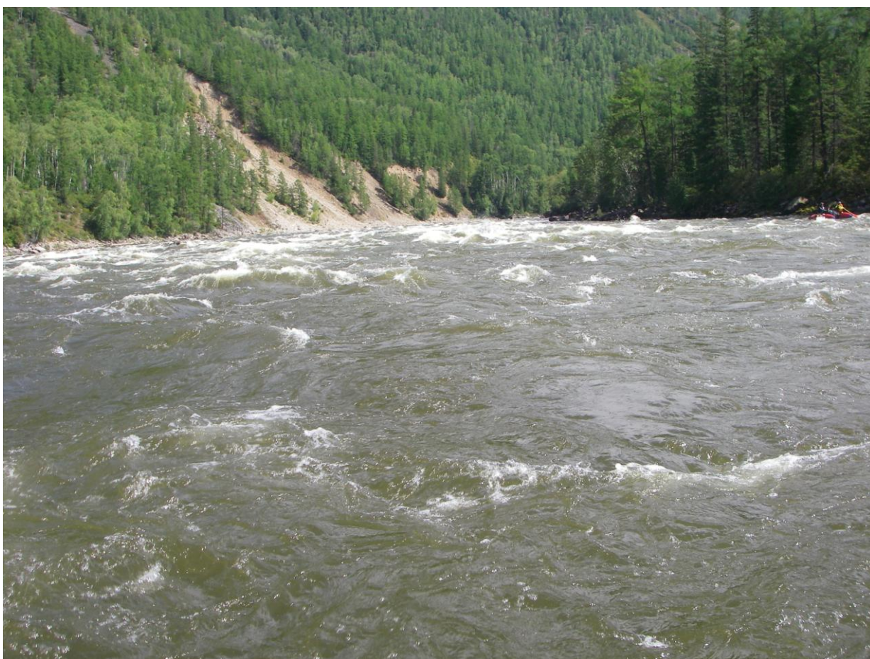
Фото 28. Шивера «Звонкая» по окончании порога «Байбальский»,
